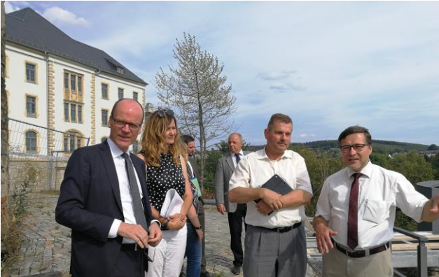
Baustellenrundgang, im Hintergrund das ehemalige Gerichtsgebäude, zukünftig mit Lehrräumen und Laboren.
