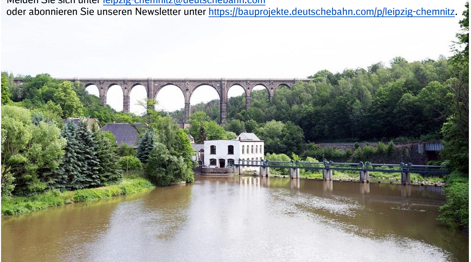
Göhrener Viadukt (DB Netz AG/Louisa Behnke)
